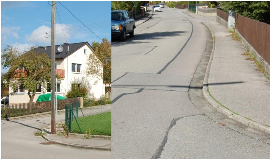
Situation der Gehwege in der Siedlung
