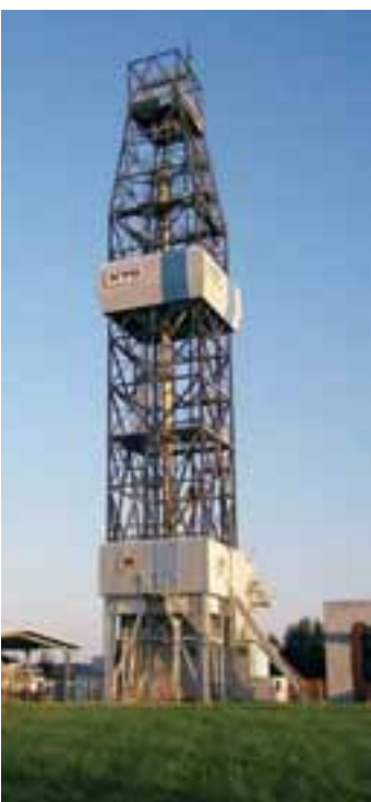
H6 | Umweltbildungseinrichtung unterm Bohrturm – das Geo-Zentrum an der KTB.
