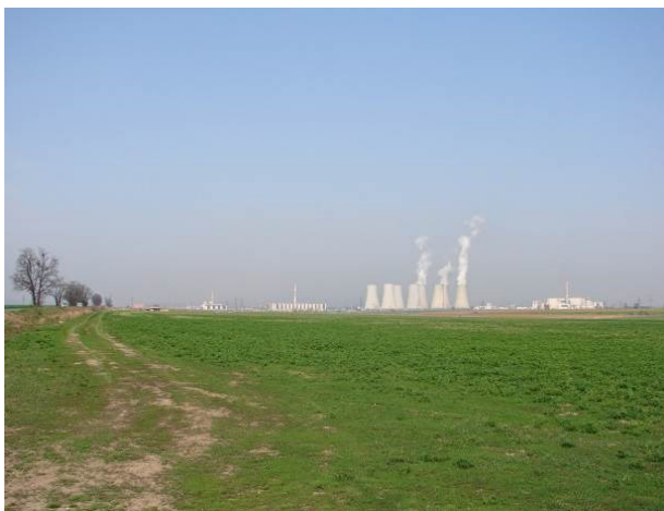
Abb. C.III.5 Ansicht von Žilkovce (bestehender Stand ohne NJZ, Zielzustand mit NJZ)
