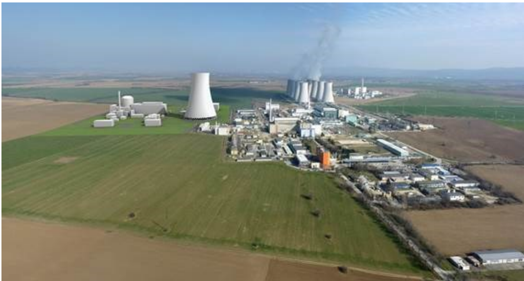
Abb. C.III.10: Gesamtansicht auf das Gelände NJZ und EBO
