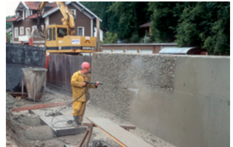
Oberflächenbehandlung der Hochwasserschutzwand in Traunstein (Foto: © WWA Traunstein)
