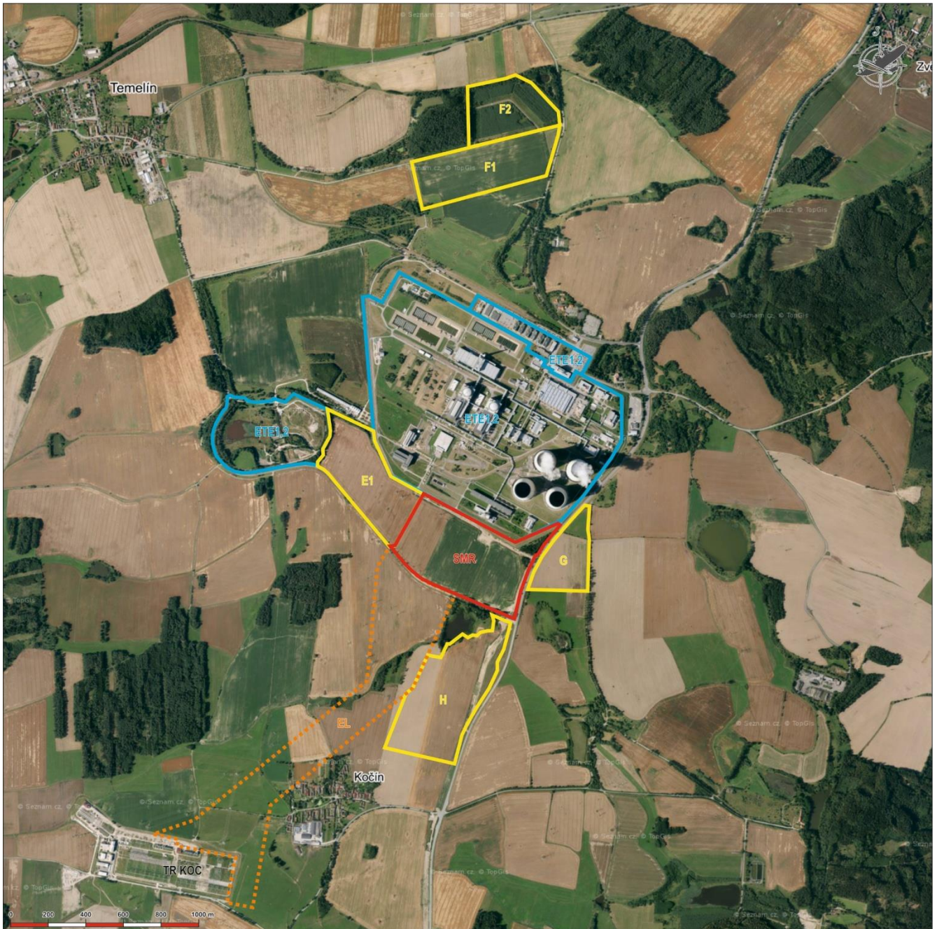
Abb. G.2: Übersichtliche Situation der Platzierung des Vorhabens
